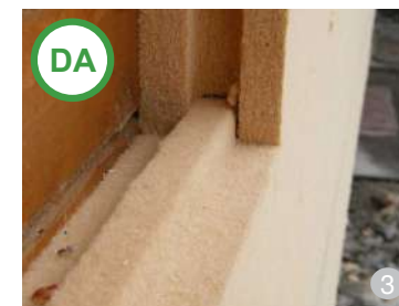
AȘA DA: Termoizolație fibrolemoasă. Produs fabricat din materii prime naturale, utilizând tehnologii moderne și prietenoase cu mediul. Fiind permeabilă la vaporii de apă, păstrează structura casei în stare uscată în mod permanent. Poate fi utilizată pentru fațadă, pardoseli și mansarde.
