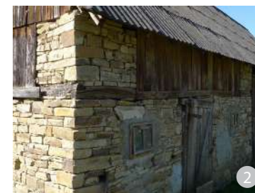
Fundațiile erau realizate din piatră atât la casele săsești, cât și la cele românești.
