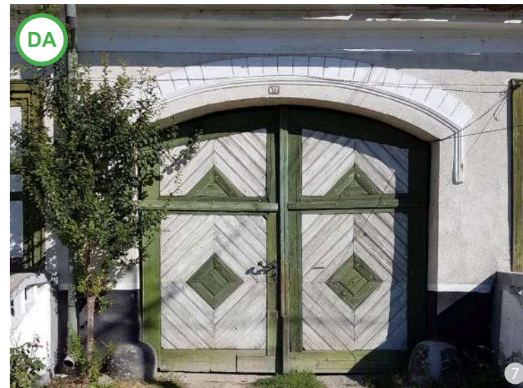
ASA DA: Poartă din lemn, inclusă în fațada clădirii, cu decorații din stucatură
