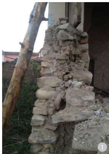
Detaliu de compunere a peretelui: două rânduri de piatră separate de un strat de 10 cm de pământ galben și cărămidă cu rol de termoizolație
