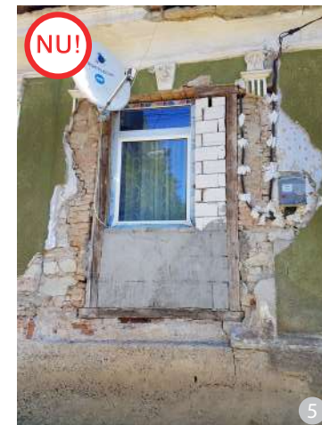
ASA NU: Caz frecvent de modificare inadecvată a golurilor ferestrelor de la fațadă
