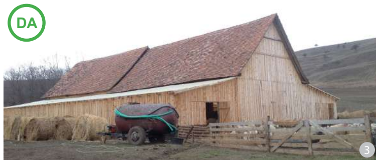
AȘA DA: Pentru construcții zootehnice, se acceptă alternarea pantei acoperișurilor, cu condiția ca volumetria de ansamblu să se încadreze în specificul local, precum acest adăpost pentru animale.
