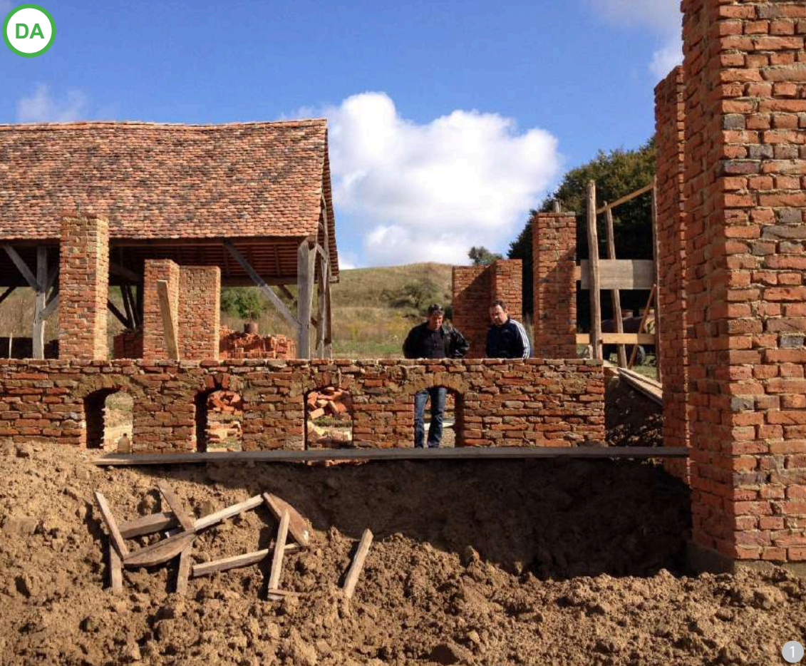
ASA DA: Construcție nouă cu pereți și stâlpi din cărămidă și beton: cărămida tradițională, prin dimensiunile ei mici, se adaptează ușor la orice configurație planimetrică, chiar și în detaliu.
