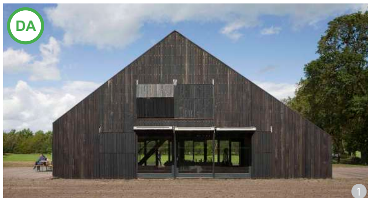
AȘA DA: Construcție agricolă care respectă regulile de încadrare în specificul local: forma acoperișului, folosirea lemnului (material sustenabil și local), atât pentru structură, cât și pentru placarea fațadei.
