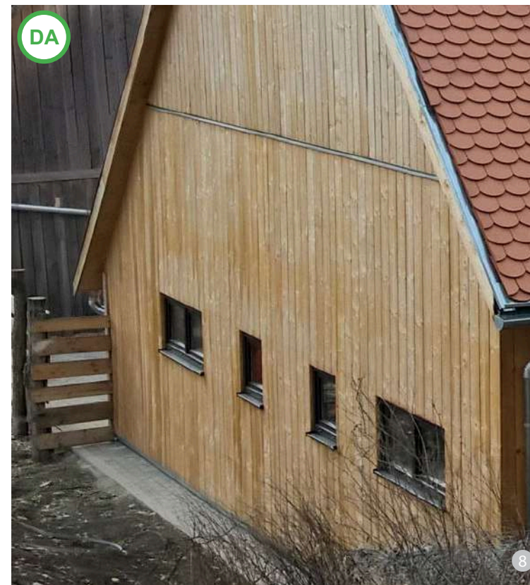
ASA DA: Alegerea sistemului de construcție cu finisaje din lemn permite dimensionarea streșinii la valoarea ei maximă: 25 cm.
