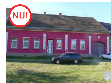
ASA NU: Clădire tradițională după intervenție: s-au îndepărtat elementele caracteristice ale fațadei, decorațiile, tâmplăriile, cornișa, în locul cărora s-a montat o tâmplărie din PVC și fier forjat, necaracteristice zonei, s-au distrus decorațiile istorice, montându-se, probabil, în schimb, o termoizolație din polistiren, și s-a distrus cornișa.
