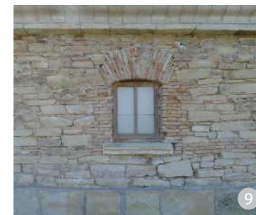
Detaliu de perete al unei case săsești, cu pereți din piatră și cărămidă și soclu și cornișă din piatră
