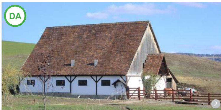
AȘA DA: Construcție agricolă care respectă cele mai importante reguli de încadrare în specificul local, inclusiv forma acoperișului, cu o pantă de 55%.
