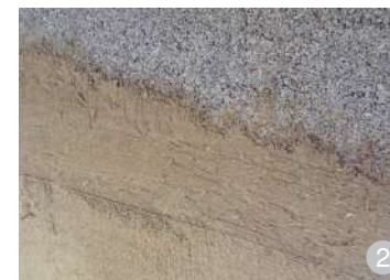
AȘA DA: Pereți termoizolanți din Hempcrete
