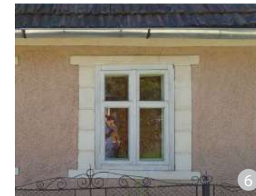
Ferestrele românești sunt, în general, compuse din două foi de geam, cu înălțimea mai mare decât lățimea, cu patru canaturi, cu tâmplărie din lemn vopsit.
