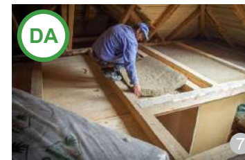
AȘA DA: Termoizolația din lână este deosebit de recomandată. Folosirea unei izolații din lână sprijină o industrie a prelucrării produselor locale: în mod frecvent, lâna se aruncă, în loc să fie utilizată. Această măsură este încă la început în țara noastră, dar se folosește cu succes și pe scară largă în majoritatea țărilor europene.
