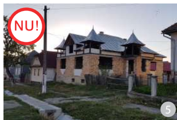
ASA NU: Nu se acceptă turnuri, balcoane și alte forme nespecifice pentru acoperişuri.
