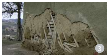
Detaliu de parament al unei case din lemn: tencuială din lut cu armătură din paie și cărămidă
