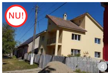
ASA NU: Complicarea volumului acoperişului are un efect neplăcut asupra imaginii de ansamblu a construcției și a împrejurimilor; în plus, crește riscul de infiltrații în punctele de contact cu pereții.
