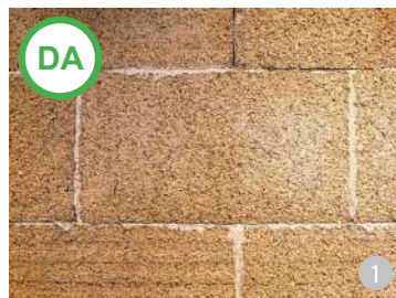
AȘA DA: Casă cu structură de lemn și pereți din amestec de cânepă cu var stins (hidraulic): denumirea materialului este Hempcrete (Hemplime).
