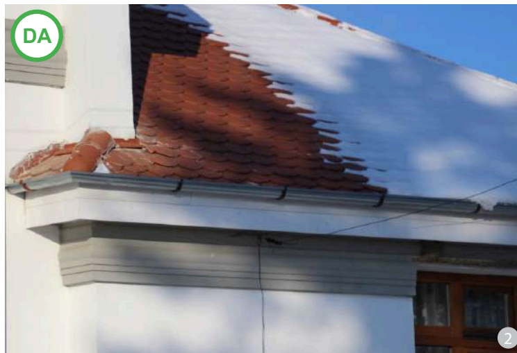
AȘA DA: Esențializarea unor forme ale arhitecturii vernaculare precum brăul de streșină din imagine poate fi de bun augur pentru tendința de încadrare în specificul local. Se recomandă ca acestea să nu fie confecționate din poliester, ci să se apeleze la o echipă de meșteri locali.
