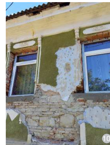
Pereți masivi din piatră, atât la nivelul demisolului, cât și la cel al parterului
