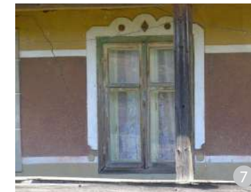
Ferestrele românești sunt, în general, compuse din două foi de geam, cu înălțimea mai mare decât lățimea, cu patru canaturi, cu tâmplărie din lemn vopsit.
