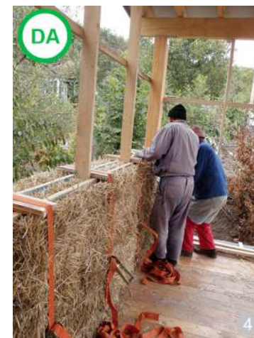
AȘA DA: Casă cu structură din lemn și pereți din baloți de paie sau pereți din blocuri de argilă, amestecată cu paie.
