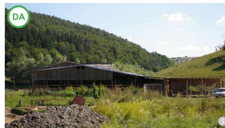
AȘA DA: Pentru camuflarea gabaritelor, sunt permise acoperișurile cu înclinație mică cu învelitoare din tablă sau acoperișurile verzi. În imagine, se observă intenția de încadrare în peisaj prin folosirea unor pante reduse ale acoperișului și limitarea înălțimii construcției. Aceste procedee se pretează la clădiri de dimensiuni foarte mari, precum săli de sport, hale de producție, spații de depozitare a cerealelor etc.
