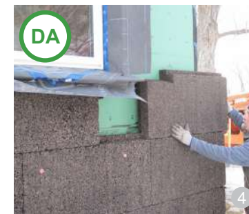
AȘA DA: Plăci izolatoare din plută expandată
