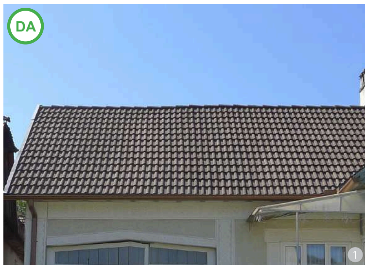
Învelitoare din țiglă care respectă modelul tradițional, atât din punct de vedere coloristic, cât și ca formă. În zona studiată, specificul local este reprezentat de țiglele ceramice de tip solzi și de țiglele profilate.
