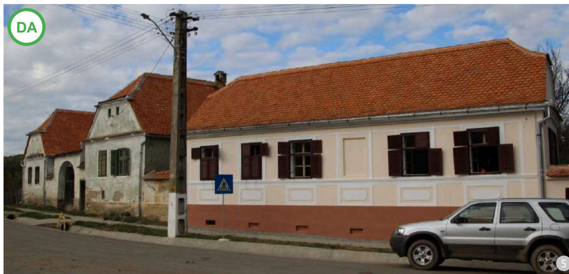
AȘA DA: Țiglă veche arsă din nou, folosită pentru acoperirea unor pensiuni turistice
