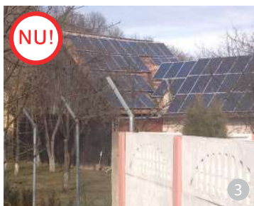
ASA NU: Acoperirea totală a învelitorii cu panouri fotovoltaice face ca acestea să se substituie ele însele învelitorii și să influențeze într-un mod neplăcut imaginea de ansamblu a clădirii.
