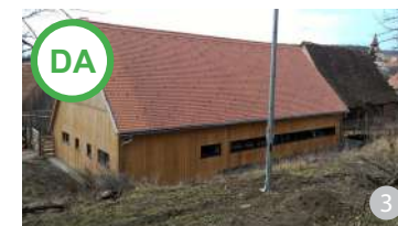
AȘA DA: Finisajul cu lambru de lemn după dimensiunile locale este varianta optimă pentru clădirile de orice dimensiune.
