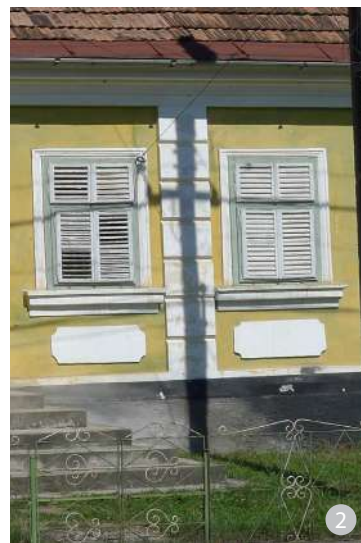
Obloane cu gradene, de formă dreptunghiulară sau cu arc la partea superioară, specifice caselor tradiționale săsești
