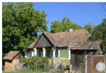
Învelitoare tradițională, din țiglă profilată, atât pentru locuință, cât și pentru anexele gospodărești
