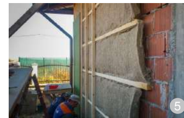
AȘA DA: Termoizolația din lână este deosebit de recomandată. Folosirea unei izolații din lână sprijină o industrie a prelucrării produselor locale: în mod frecvent, lâna se aruncă, în loc să fie utilizată. Această măsură este încă la început în țara noastră, dar se folosește cu succes și pe scară largă în majoritatea țărilor europene.
