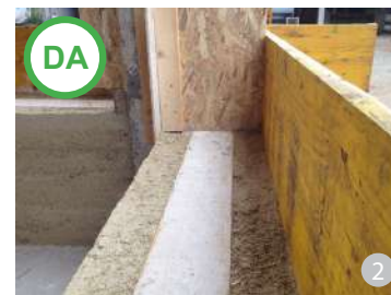
AȘA DA: Casă cu structură de lemn și pereți din amestec de cânepă cu var stins (hidraulic): denumirea materialului este Hempcrete (Hemplime).
