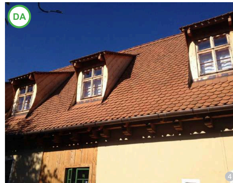
AȘA DA: Țiglă manuală nouă utilizată la o pensiune turistică – proiect realizat cu finanțare europeană
