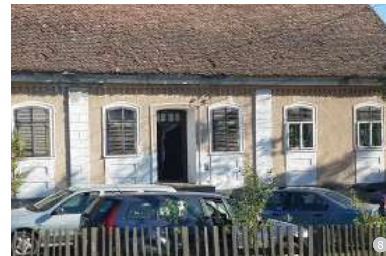
Clădire la care se întâlnesc ambele tipuri de ferestre, pentru fiecare sezon: la ferestrele din partea stângă, există un strat de geam dublat de un oblon – soluție pentru perioada de vară; la ferestrele din partea dreaptă, oblonul este înlocuit de un alt doilea strat de geam, pentru o termoizolare mai bună (soluție pentru timp de iarnă).
