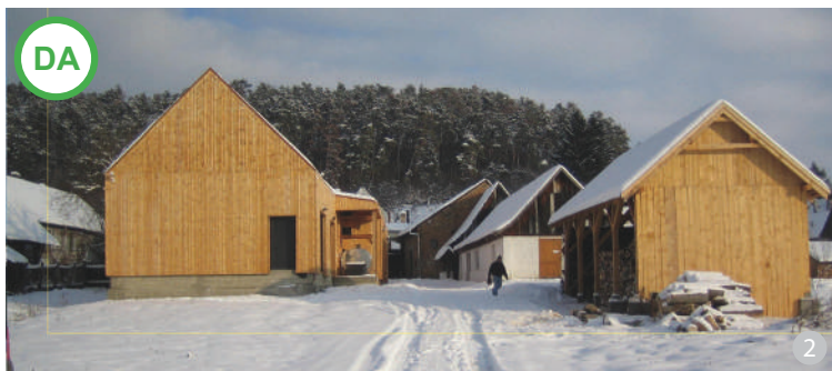
ASA DA: Acoperişul respectă panta minimă de 45 % a construcțiilor din vatra satului.
