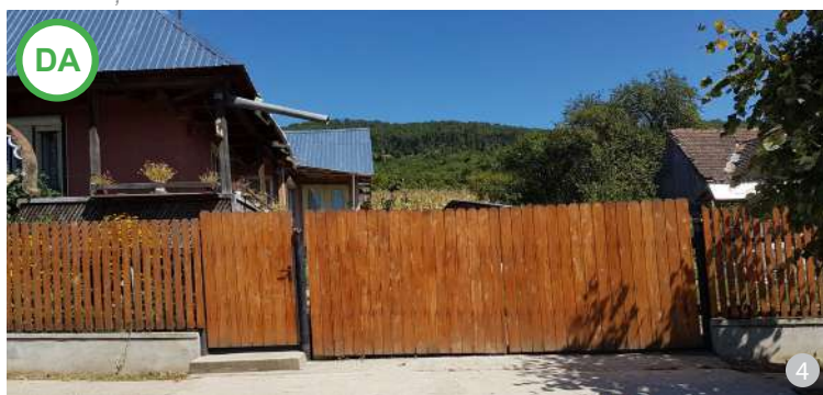
ASA DA: Reconstrucția unei porți și a unui gard după un model local românesc
