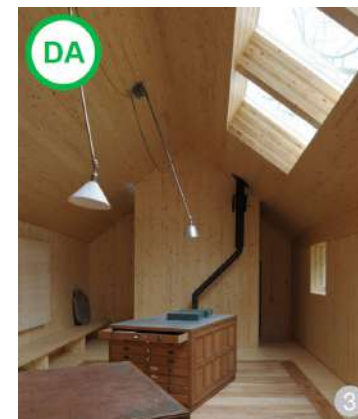
AȘA DA: Casă cu structură din panouri de lemn lamelar încleiat: denumirea materialului este CLT (Cross-Laminated Timber).
