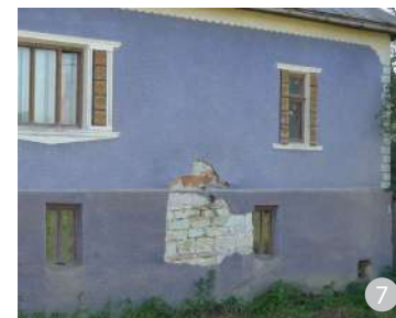
Casă românească cu pereți de cărămidă, așezați pe un demisol construit din piatră
