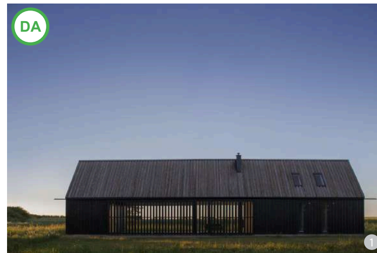
ASA DA: Necesitatea de lumină poate constitui un factor decisiv în arhitectura unei fațade, oferind posibilități diverse. Se impune respectarea proporțiilor și a formelor golurilor tradiționale. În exemplul de față, se observă transpunerea raportului plin/gol din modelul șurii tradiționale.
