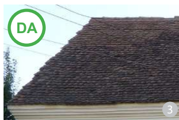
AȘA DA: Acoperiș tradițional din țiglă de tip solzi. Se recomandă menținerea tipului de învelitoare odată cu schimbarea/completarea ei.
