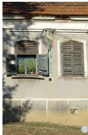
Obloane cu gradene, de formă dreptunghiulară sau cu arc la partea superioară, specifice caselor tradiționale săsești
